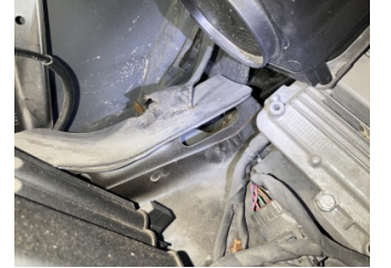
Kaporta, Sol Kılıç Sacı > Hasarlı
