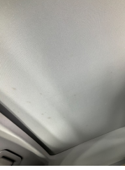
Döşemeler/Kapaklar, Döşemeler/Kapaklar > Kirlenmiş
