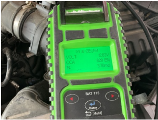
Elektrik donanımı/Pano, Akü > Test Sonucu
