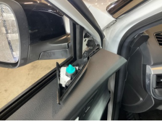
Döşemeler/Kapaklar, Kapı döşemesi, sol ön > Sabitlemesi Hatalı
