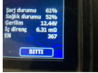
Elektrik donanımı/Pano, Akü > Test Sonucu
