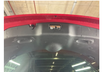
Döşemeler/Kapaklar, Döşemeler/Kapaklar > Deforme Olmuş
